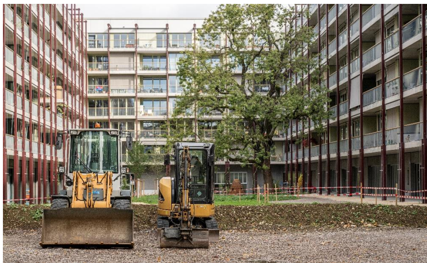
Abbildung 22: Baumaschinen im Westfeld (Foto: Pascal Mora/ARE ©)
