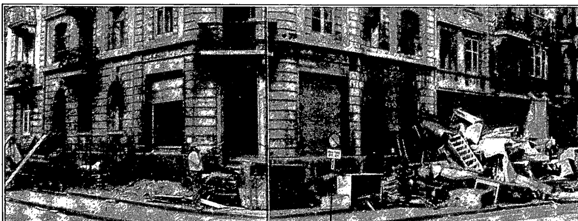
Abriss eines Eckhauses im Jahr 1970
