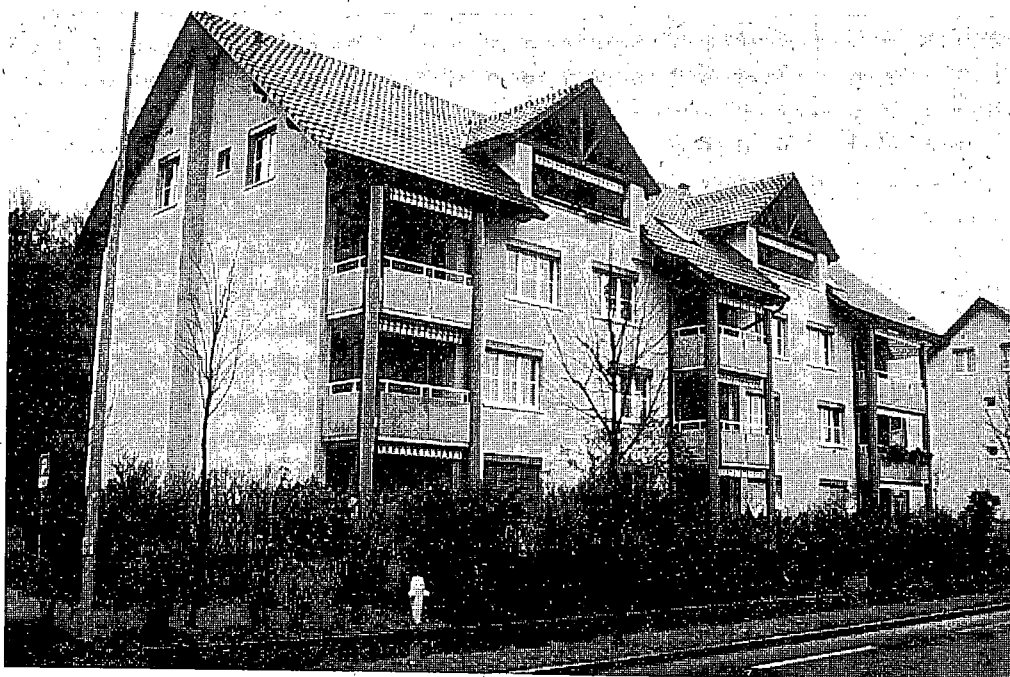
Abb. 5: Wohnhaus Stettenerstrasse 149, Schaffhausen Herblingen.
