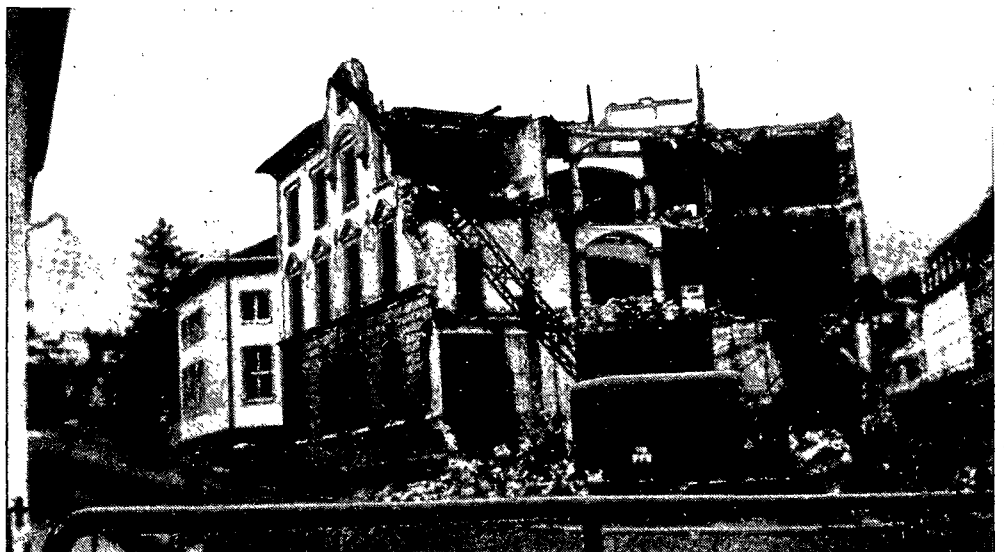
Abbruch der alten Post Grenchen (ca. 1955)
