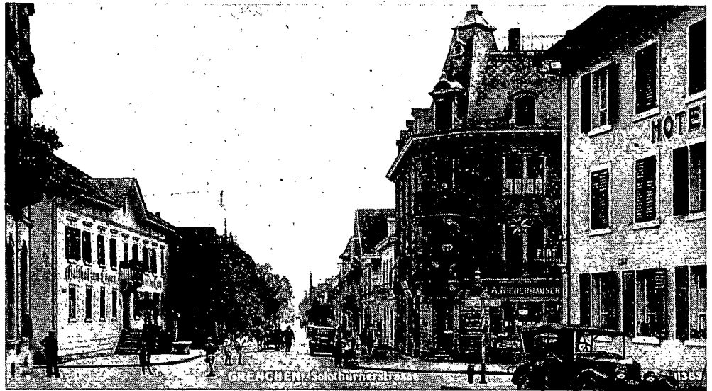
Fussgänger, Autos, Fuhrwerke und Leiterkarren verkehrten friedlich auf der Hauptstrasse. (1931)
