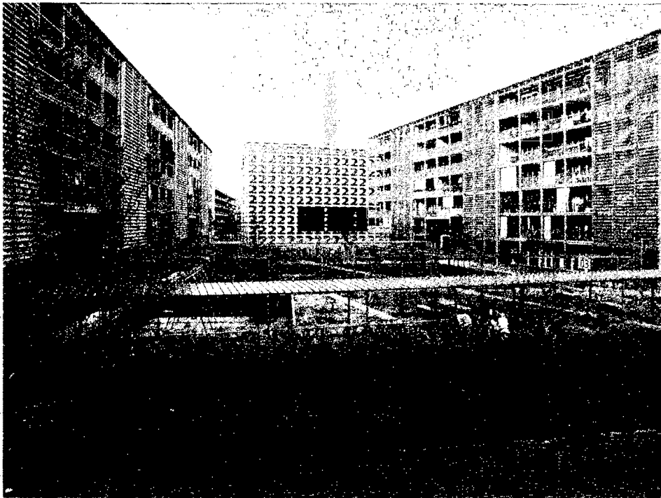
Innenhof Regina-Kägi-Hof mit Heizzentrale im Hintergrund
