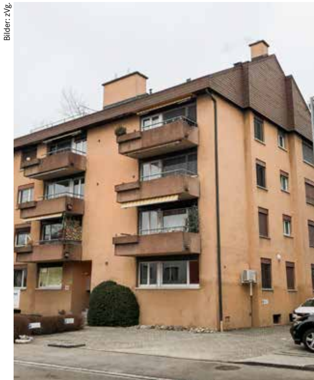
Das Mehrfamilienhaus der Wohnbaugenossenschaft Gewo Zürich-Ost in Uster zählt zu den ersten Sanierungsprojekten, die vom FdR-Sonderprogramm profitiert haben (Details siehe Folgeseite). Unter anderem erhielt es eine vorgehängte hinterlüftete Fassade.
