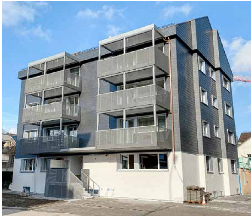
Das Mehrfamilienhaus der Wohnbaugenossenschaft Gewo Zürich-Ost in Uster zählt zu den ersten Sanierungsprojekten, die vom FdR-Sonderprogramm profitiert haben (Details siehe Folgeseite). Unter anderem erhielt es eine vorgehängte hinterlüftete Fassade.
