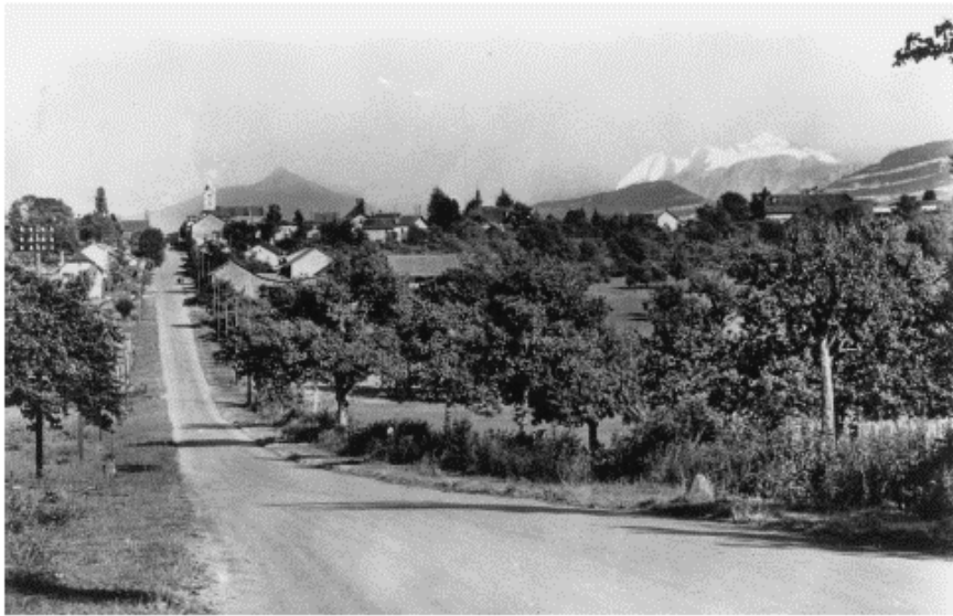
Route de Meyrin, ACM
