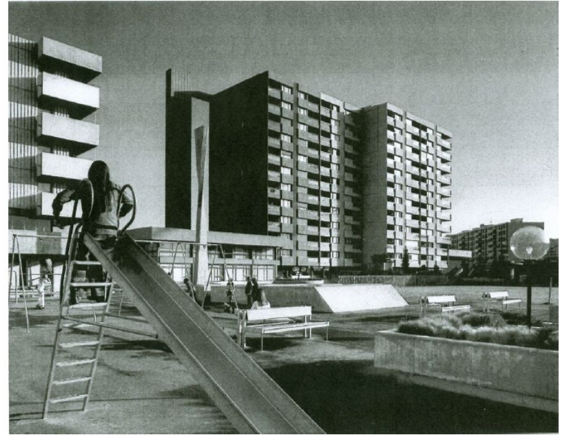
Champs Fréchets, années 70, photo des architectes
