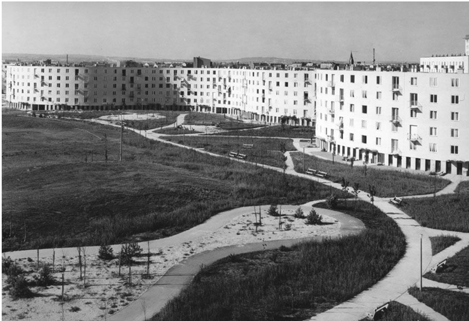
Photographie du grand ensemble Les Courtilières à Pantin en 1959. Source : Henri Baranger, Fonds Émile Aillaud. SIAF/Cité de l'Architecture et du Patrimoine / Archives d'Architecture du XX e siècle. 078 IFA 2002/4.
