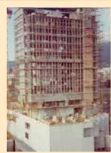
Hier sieht man wie das Centro früher gebaut wurde, wie die Arbeiter fast am Ende waren mit den Bauarbeiten.
