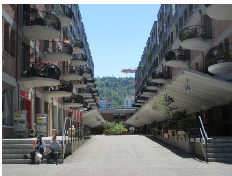
Blick in die Marktgasse mit Aufgängen zur ehemaligen Anlieferungszone.
