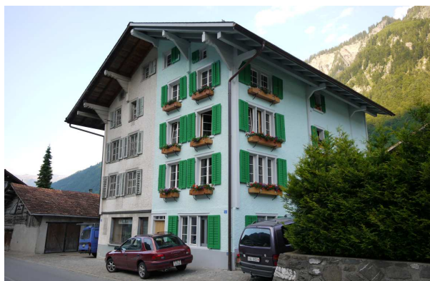
Abbildung 25: Glarnerhaus im Zentrum von Rüti (eine Seite renoviert, die andere z.T. leerstehend)
