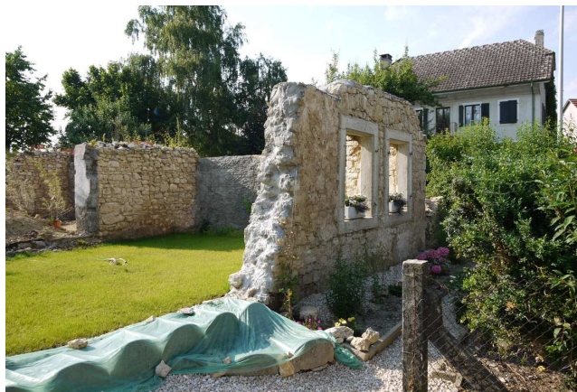
Abbildung 30: Rückbau mit anschliessender Gartennutzung in Vendlincourt
