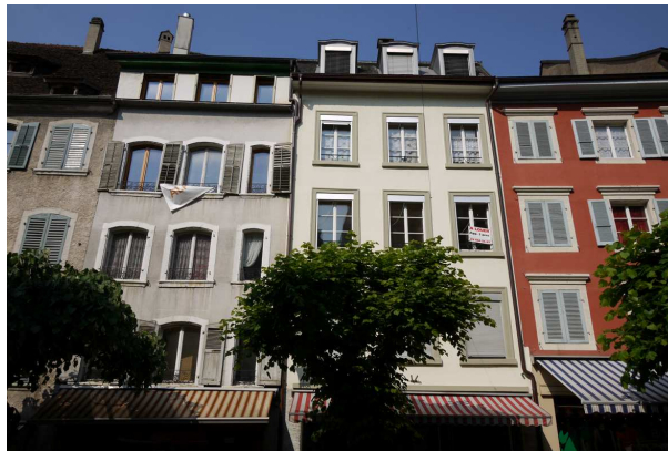
Abbildung 26: Typische, teilweise leerstehende Mehrfamilienhäuser in der Altstadt von Porrentruy
