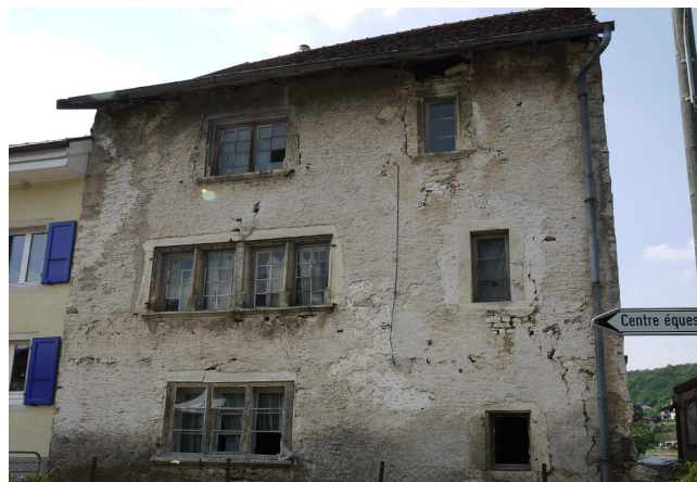
Abbildung 29: Leerstehende Liegenschaft mit „Rückbaupotenzial“ in Chevenez
