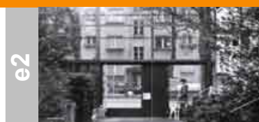
Lärmschutzwand Ostring, CH-Bern Schutz von Höfen mit gestalteter Wand
