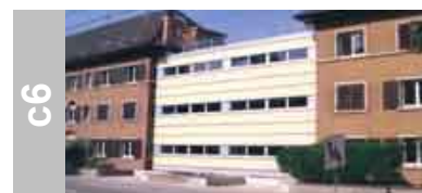
Winterthurerstrasse 11-117, CH-Zürich Schliessen einer Lücke bei 2 Längsbauten
