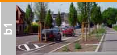
Beruhigung Obertürkheimstrasse, D-Esslingen Beruhigung Ausfallstrasse, Umleitung und Verengung
