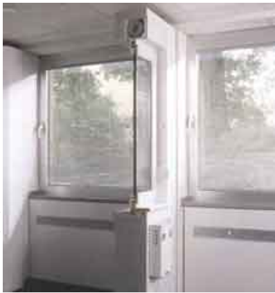
Dämmung Rollladenkasten (Musterraum)
