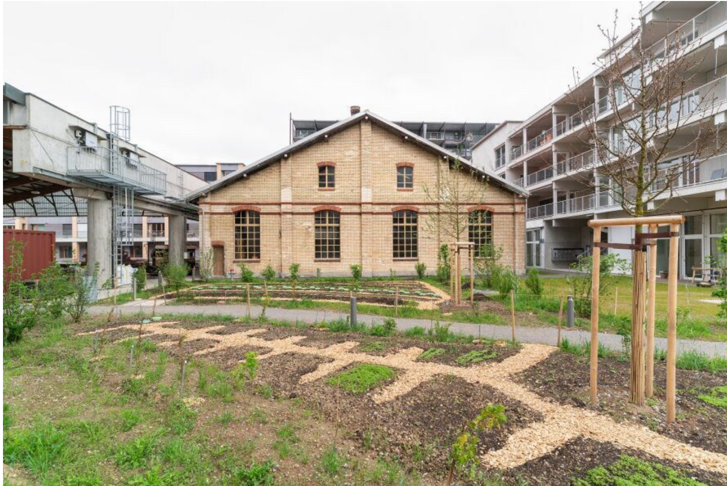
Altes Hobelwerk, Oberwinterthur ZH
